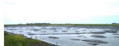
Slika 8 Izgled prekrivene lagune
